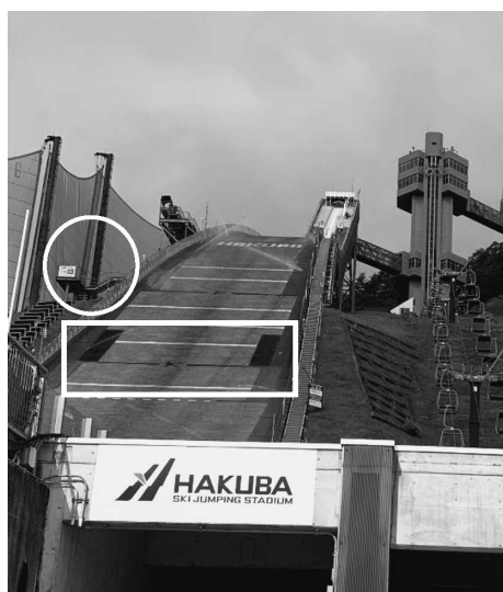
図1 白馬ジャンプ競技場ノーマルヒル。□で囲まれた場所が踏切地点であり、フォースプレートが埋め込まれている。○で囲まれた場所がコーチングボックスである
